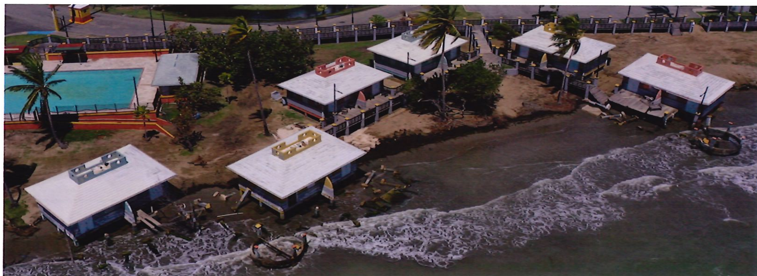
Estado de las villas vacacionales del Centro Vacacional Punta Guiltarte luego del huracán Fiona en el año 2022. La imagen fue suministrada por Jey Clemente de SDPM.
